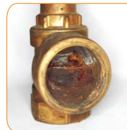
Ablagerungen in Rohren und Ventilen
